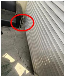
图 9 地面崩裂的水泥
